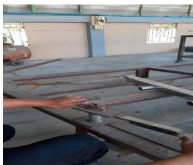
ภาพที่ 6 แสดงการตัดเหล็กที่ใช้เป็นฐานของตัวตะแกรง
